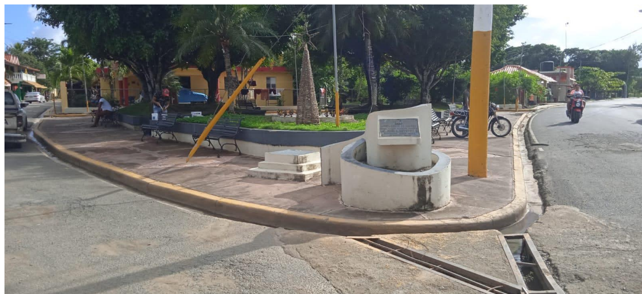
Remozamiento Parque de la comunidad Hato Mayor.
