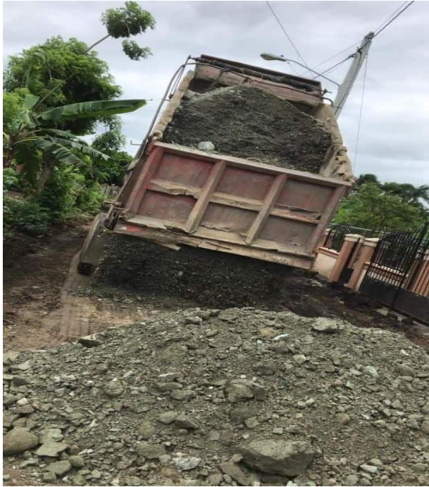
Acondicionamiento de la calle en la comunidad de Los Rojas.
