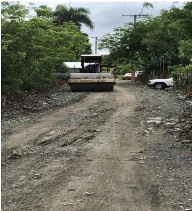
Acondicionamiento de calle en la entrada de la Planta de Tratamiento en la comunidad de Calle Del Río.
