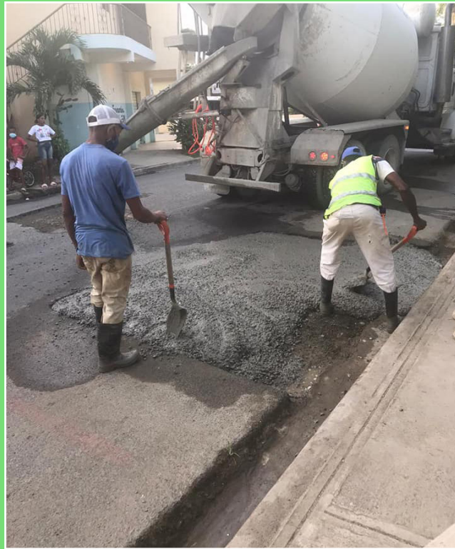
Programa de bacheo mediante el sistema de hormigón armado en las principales calles del pueblo.
