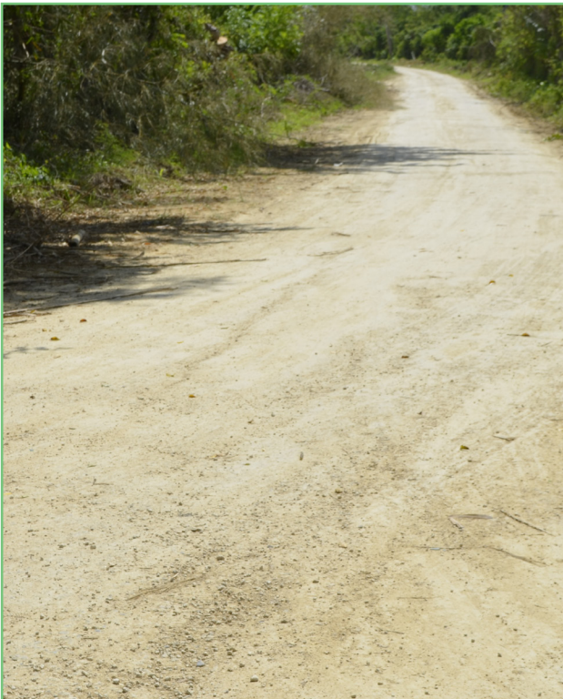
Carretera El Viso
