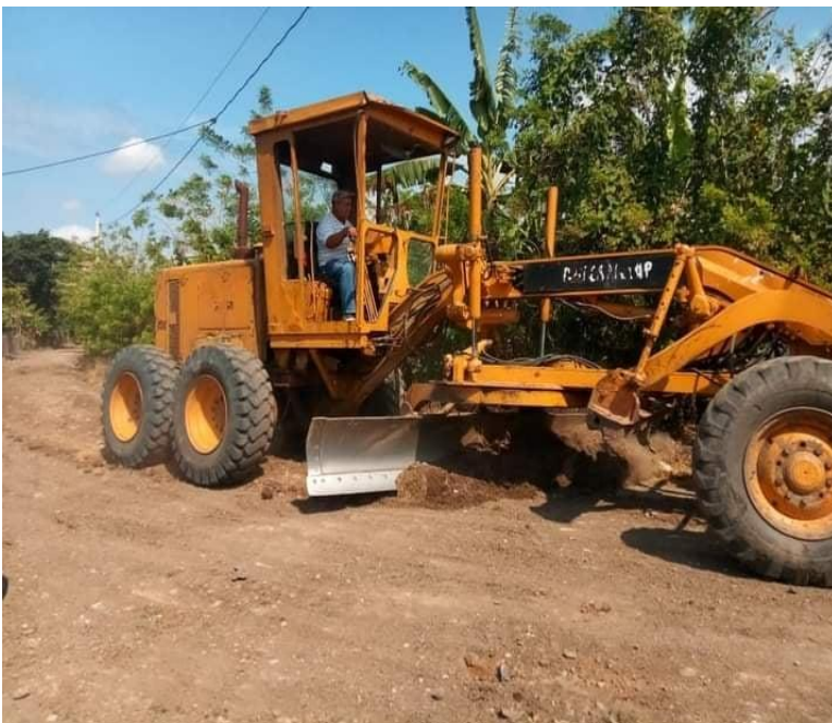
Inicio de acondicionamiento de calles de las comunidades de Calle Del Río y La Guama.
