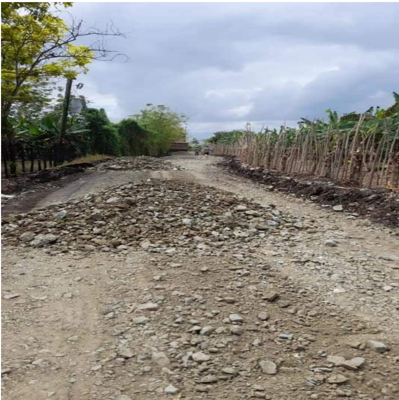
Acondicionamiento de varias entradas en la comunidad de Calle Del Río.
