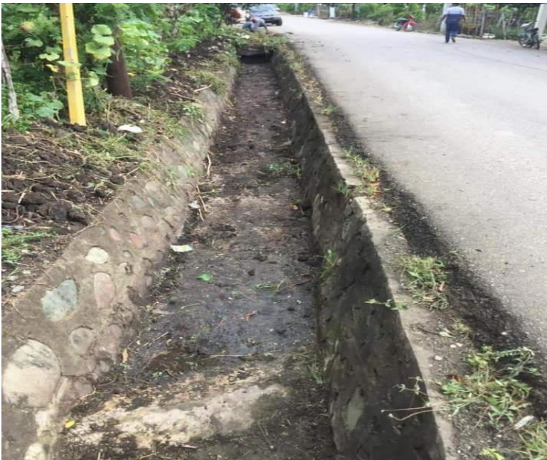
Limpieza de encache y aceras en los Capellanes.
