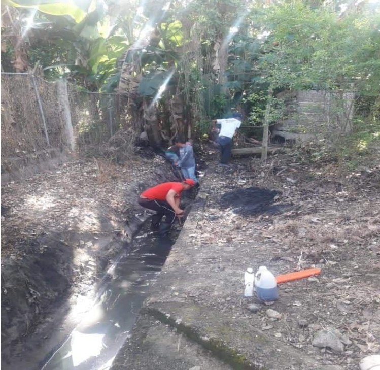
Limpieza de encache al lado del local Zeon, calle Hermanas Mirabal.
