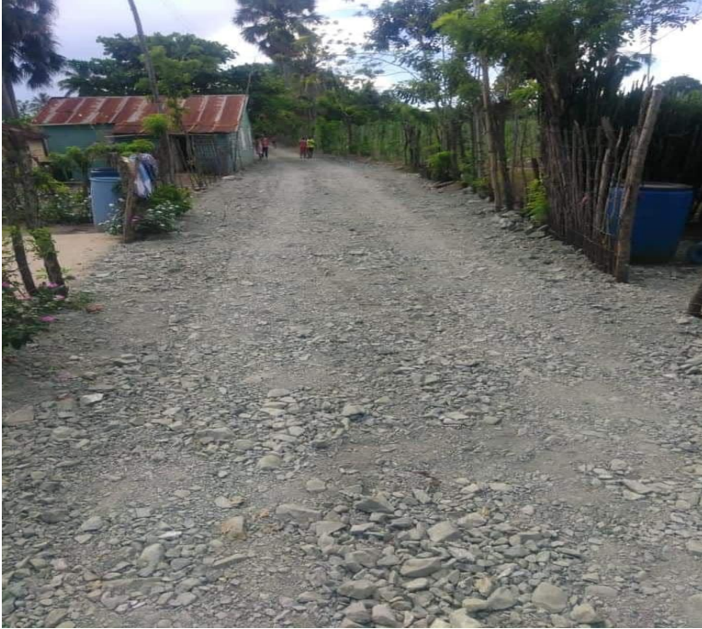
Acondicionamiento de entrada en la comunidad de Hato Viejo.
