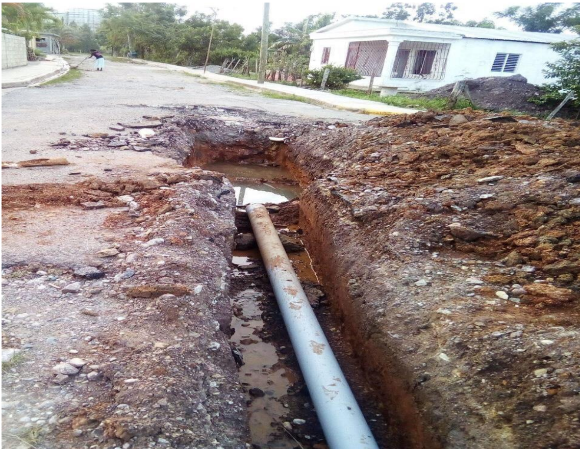
Instalación de tubos para Agua Potable
