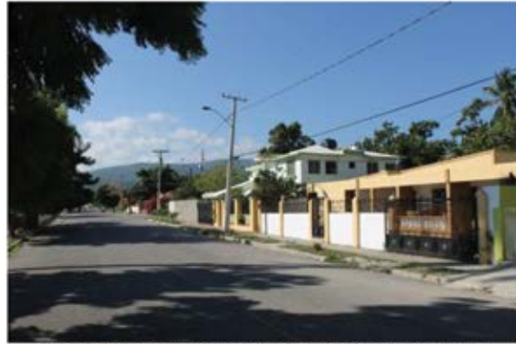
Zona de viviendas unifamiliares en el Mejoramiento Social
