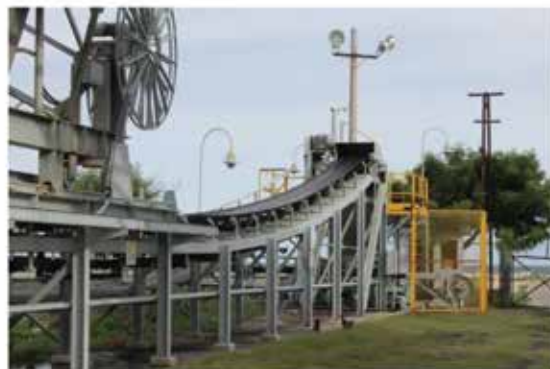
Instalaciones del muelle 6
