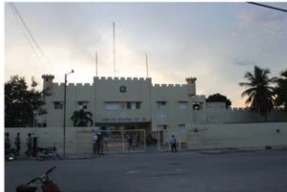
Edificio Sede Comando Regional Suroeste Policía Nacional
