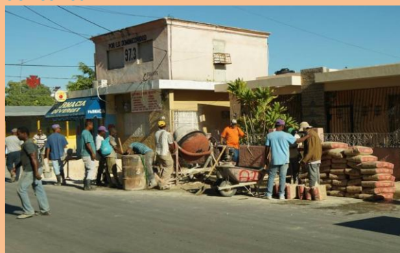
Implementación de un Plan Directo de construcción y reconstrucción de Aceras y Contenes
